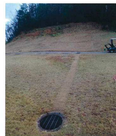
3H 法面と排水工事
