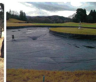
6H 池の防水工事
