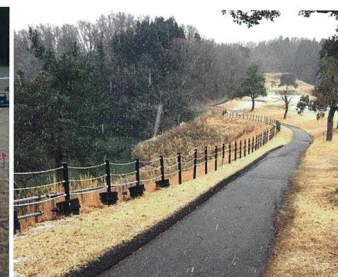
11H 防護柵設置
